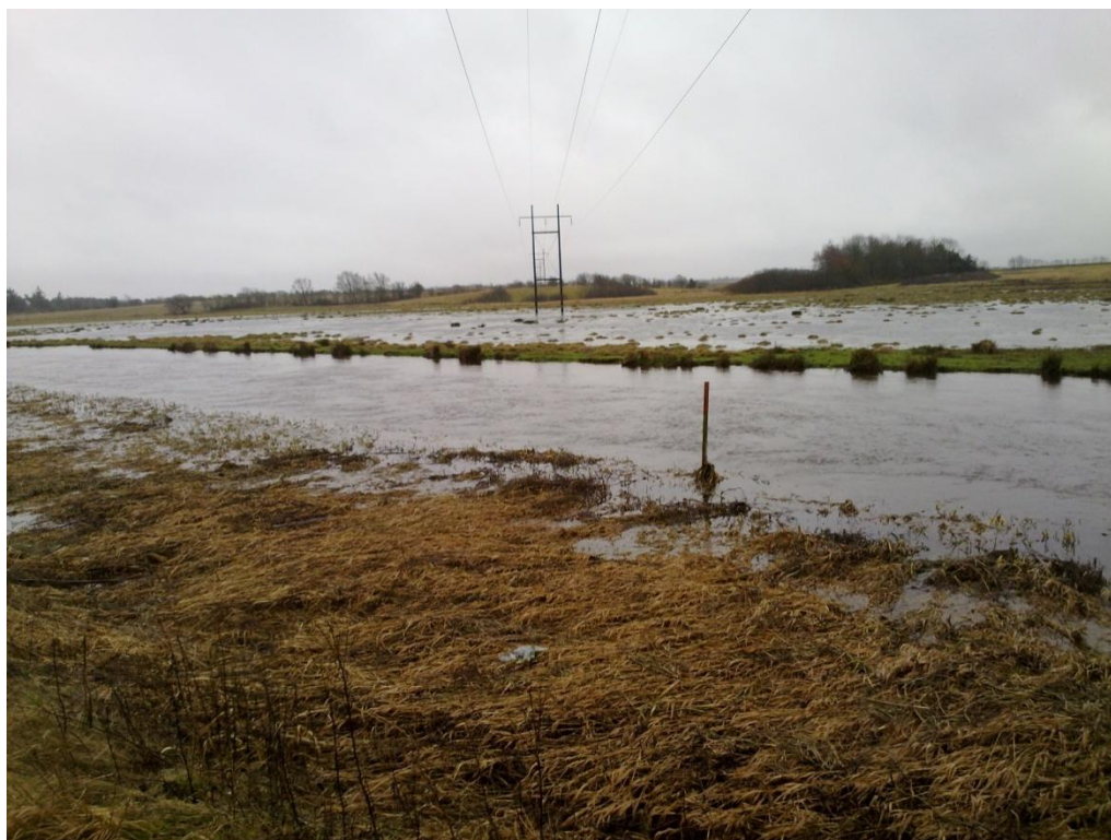
Figur 23. Højspændingsledning tilhørende Energimidt A/S, som passerer Karup Å på træmaster i vandløbets ca. st. 70500.
